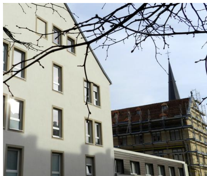
Le nouveau bâtiment de 2 500 m 2 sur quatre niveaux a été construit en parallèle de l'aile historique du couvent. Entre les deux se trouvera l'an prochain un pôle spécialisé pour l'accueil des résidents désorientés. PHOTOS DNA - G. L.
